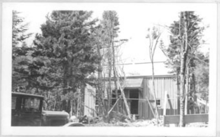
Intercept Bldg S. E. side
